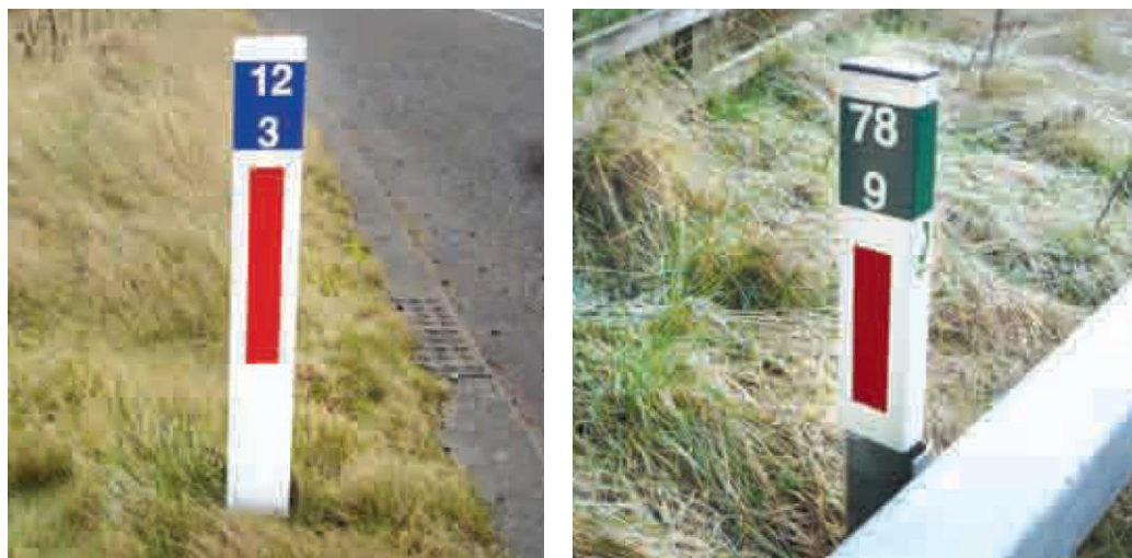
Figur 10. De mest almindelige kantpæle på motorveje (blå top på højre foto) og øvrige større veje (grøn top på venstre foto).
