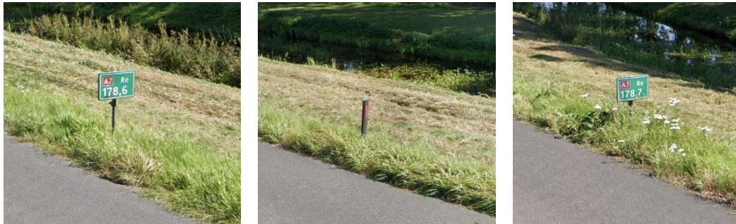
Figur 8. Kilometertavle på hollandsk motorvej med kantpæl 50 m efter og kilometertavle 50 m efter igen (fotos: Google Streetview).
