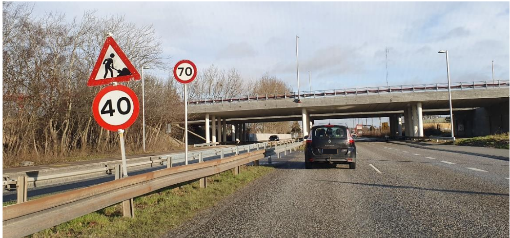
Figur 2. Varsling af vejarbejde med nedskiltet hastighedsbegrænsning og manglende demarkering af 70 km/h. Det er uklart, hvad man som trafikant kan forvente længere fremme. Er der vejarbejde eller ej, og hvilken hastighed bør man fortsætte med? Det er vigtigt, at den information vi møder er retvisende og entydig, og stemmer overens med det vi ser og forventer (foto: Trafitec).
