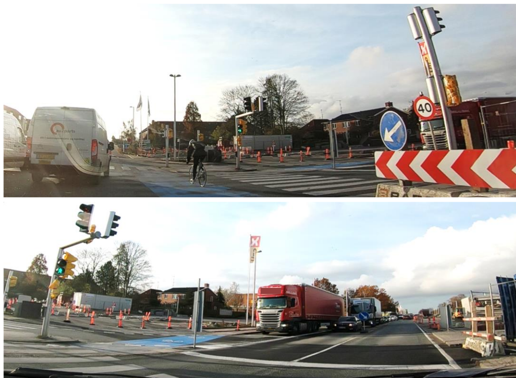
Figur 57. Ovenpå retningspilen ses påbudstavle, som formentlig er målrettet ligeudkørende trafikanter fra øst mod vest (Case 2). Drejer man køretøjet mod højre, er det første man lægger mærke til stopstregen i de to oprindelige tilfartsspor for ligeudkørende trafikanter fra vest mod øst. Stopstregerne indbyder ikke de højresvingende trafikanter til at fortsætte mod højre. I mørke eller i perioder med begrænset trafik vil tvivlen om, hvorvidt man kan svinge til højre eller ej formentlig kun være større.
