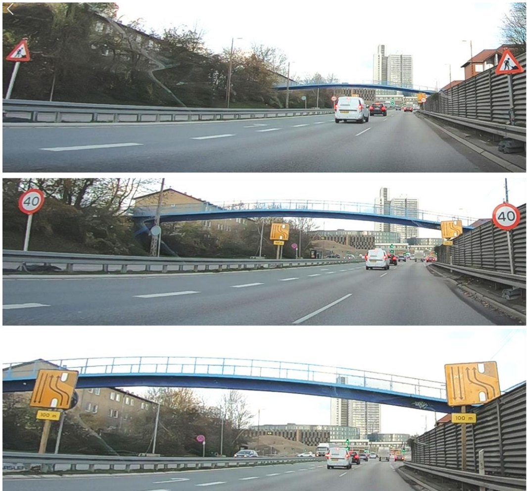
Figur 59. Varsling af vejarbejde, nedskiltning af hastighedsbegrænsning og information om ændret linjeføring 100 meter længere fremme.
