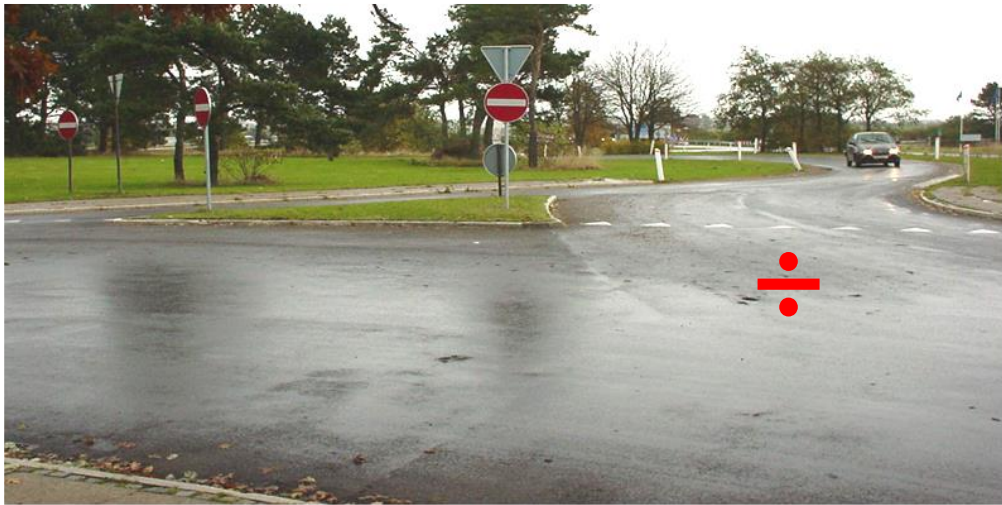
Figur 5. Rampens udmunding i krydset ender i den brede del af tragten (endda to). For trafikanterne på den krydsende vej kan det opleves som en tilkørsel til det tilstødende vejnet. Rampens udmunding i krydset følger ikke tragtprincippet.
