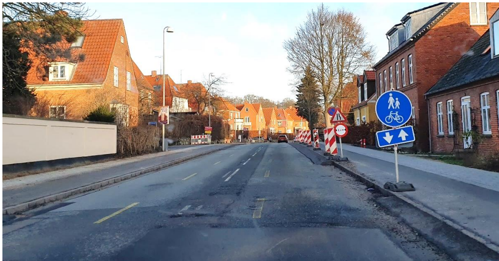
Figur 13. Eksempel på strækning hvor helhedsindtrykket er forvirrende, idet hverken skiltning eller afmærkning på vejbanen stemmer overens med det trafikanterne oplever. Her er hverken dobbeltrettet cykelsti eller indsnævring af højre vognbane længere fremme, og den gule midlertidige afmærkning er heller ikke længere aktuel. Skiltningen er ikke ændret i takt med at vejarbejdet er flyttet længere frem (foto: Trafitec).
