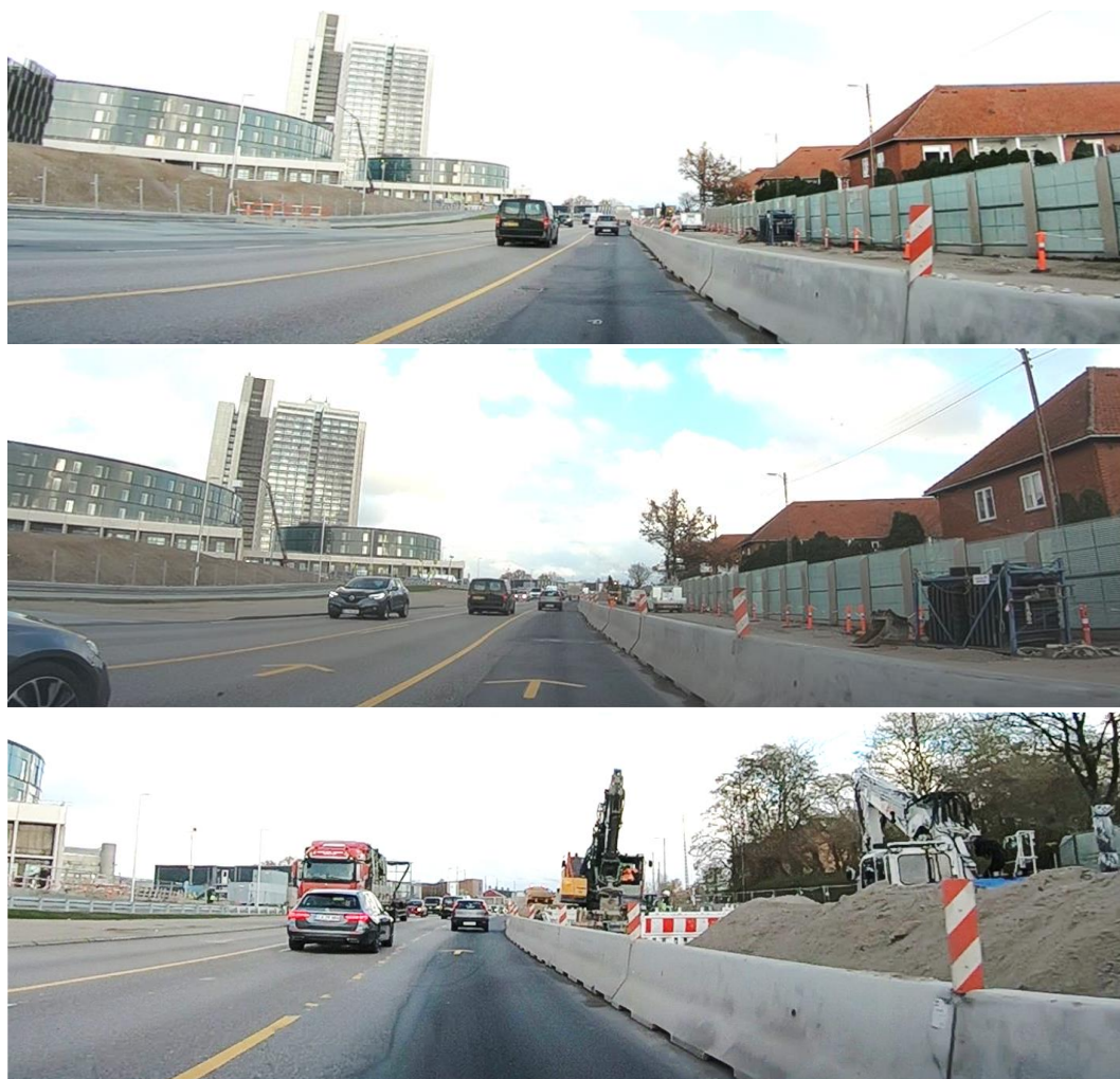
Figur 62. Overledt strækning på O3 i retning mod nord.
