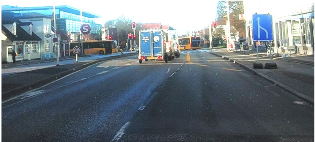
Figur 38. Uhensigtsmæssig placering af permanent E16.1.3 tavle placeret på gummifodder på cykelstien ved krydset Hovedvejen/Skolevej/Nyvej. Vejforløbet på tavlen er ikke i overensstemmelse med afmærkningen på vejen.
