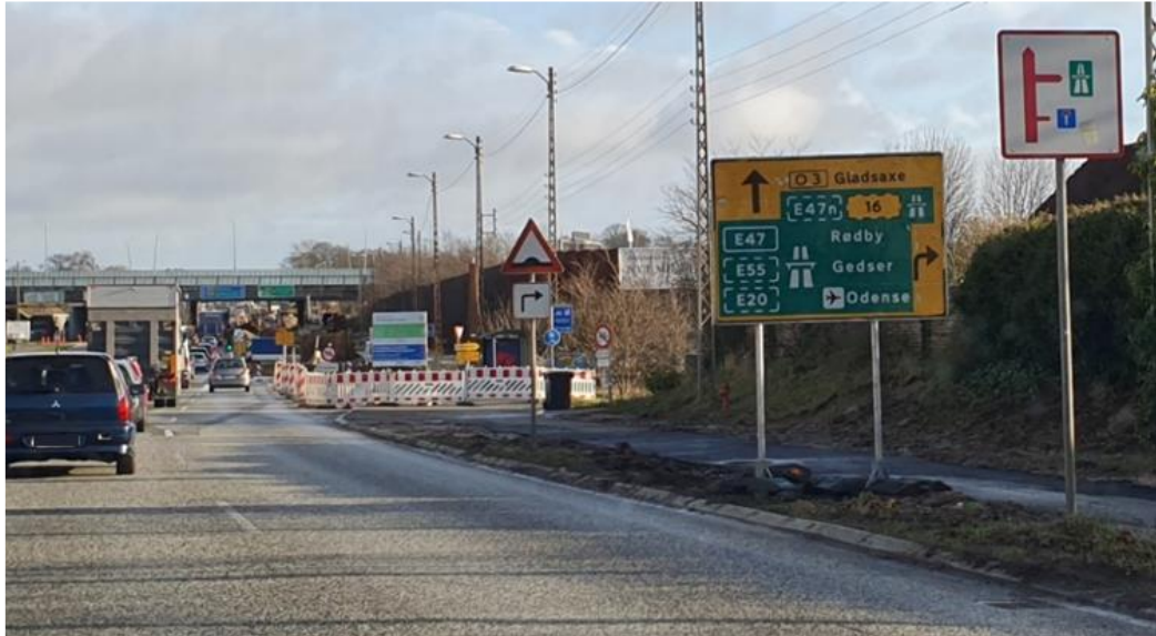
Figur 30. Placering af information der kræver trafikantens fulde opmærksomhed bør placeres på steder, hvor trafikanten kører på kontrolniveau, hvilket ikke er tilfældet her. Kombinationen af et komplekst trafikmiljø og svær forståelig vejvisning, der står tæt og har mange informationer og symboler, gør det let at køre forkert og svært at køre rigtigt (foto: Trafitec).
