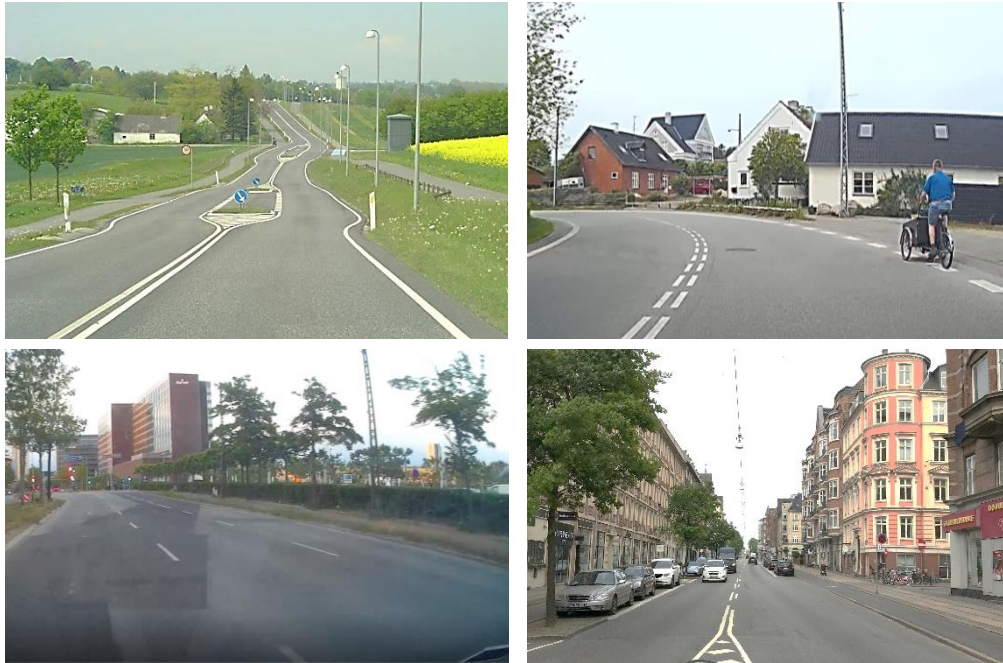
Figur 23. Fire forskellige udformninger af veje med en hastighedsbegrænsning på 50 km/h. Landlige omgivelser og brede veje indbyder ofte til højere hastighed end smalle veje med tæt bebyggelse, som mere naturligt lægger op til en hastighedsbegrænsning på 50 km/h (foto: Trafitec).
