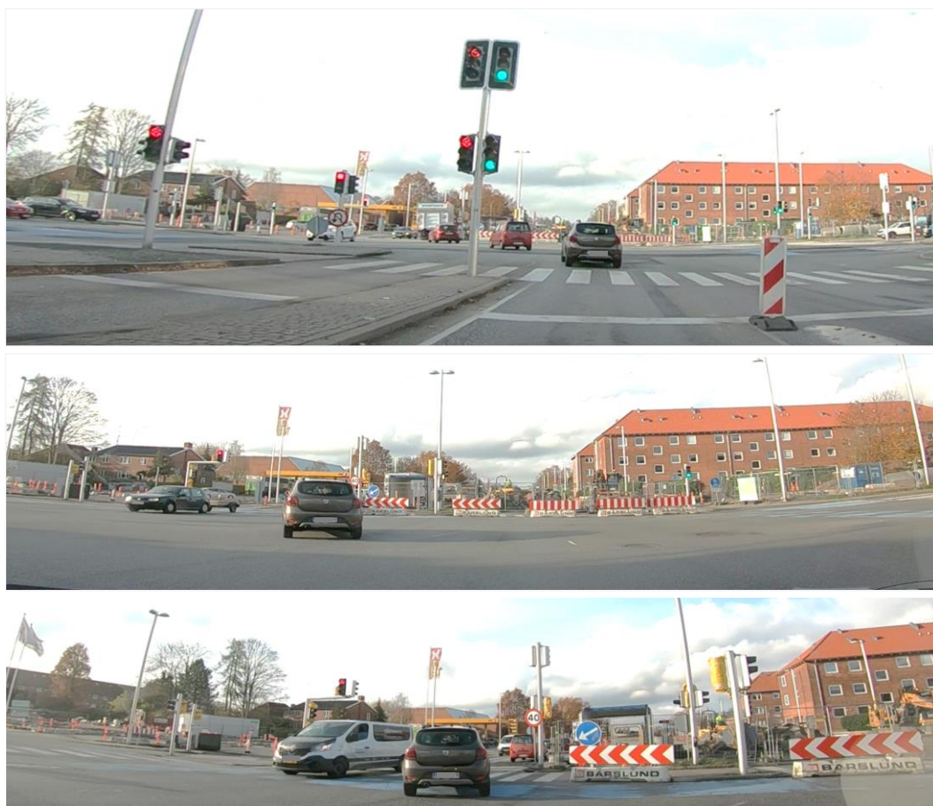
Figur 48. Retningspile (O41,2), spærrebomme (O45) og påbudstavle (D15,2) ud for de oprindelige frafartsspor.
