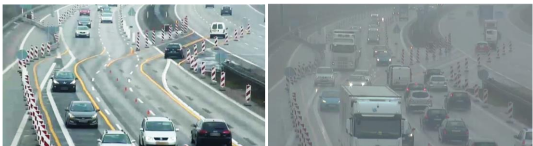
Figur 25. Kompleks tilbageledning ved vejarbejde på motorvej. Visuelt er det ikke let at navigere her, hverken i dagslys (venstre) eller i tåge (højre). Afmærkningen er langt fra retvisende eller let at forstå, og det er nemt at komme til at lave fejl med ulykke til følge. Den gule midlertidige afmærkning og den hvide permanente afmærkning giver modsatrettede signaler. Mangel på kantmærkning (N42 tavler) i tilbageledningens S-kurve medfører høj risiko for mødeulykker (fotos: Vejdirektoratet – ptz cams).
