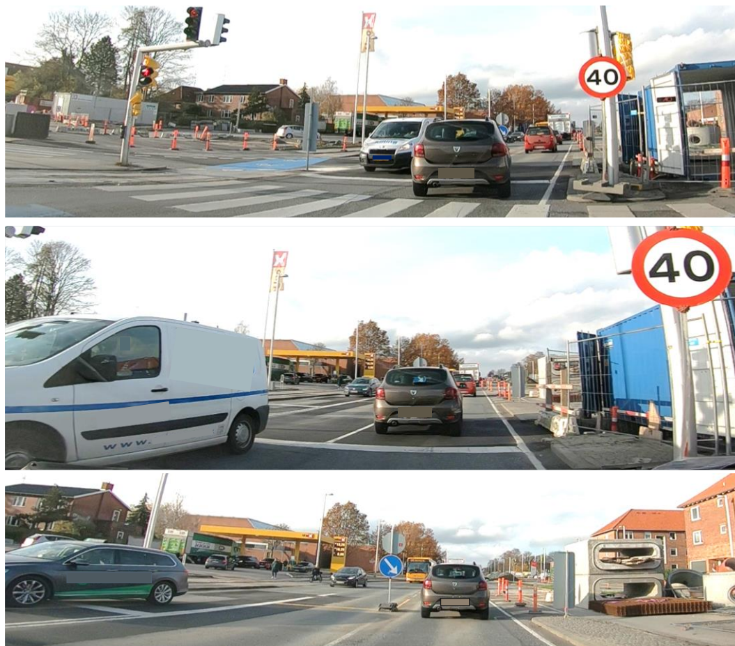
Figur 49. Trafikanter der passerer Ringvejskrydset fra øst mod vest ledes over i modsatrettede kørebanelhalvdel på Hovedvejen (O3) i den oprindelige venstre af to ligeudbaner.
