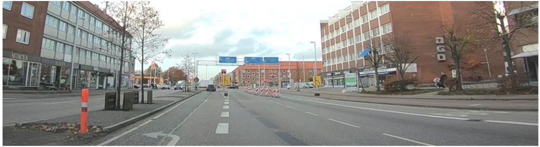
Figur 43. På dette sted skulle der ifølge de midlertidige E16.3.1 tavler hhv. ca. 100 meter længere tilbage (Figur 42) og ca. 30 meter længere fremme – være én vognbane. Trafikanterne oplever dog noget andet: én venstresvingsbane, to ligeudbaner og én busbane.
