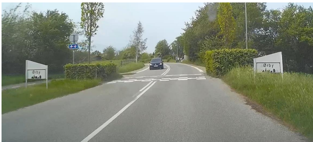
Figur 14. Byporten markerer overgangen mellem land og by. Bump med brostensbelægning, fuldt optrykket midtlinje og beplantning i byporten samt ophævelse af dobbeltrettet cykelsti signalerer både visuelt og fysisk, at man som trafikant kører ind i et andet trafikmiljø (foto: Trafitec).
