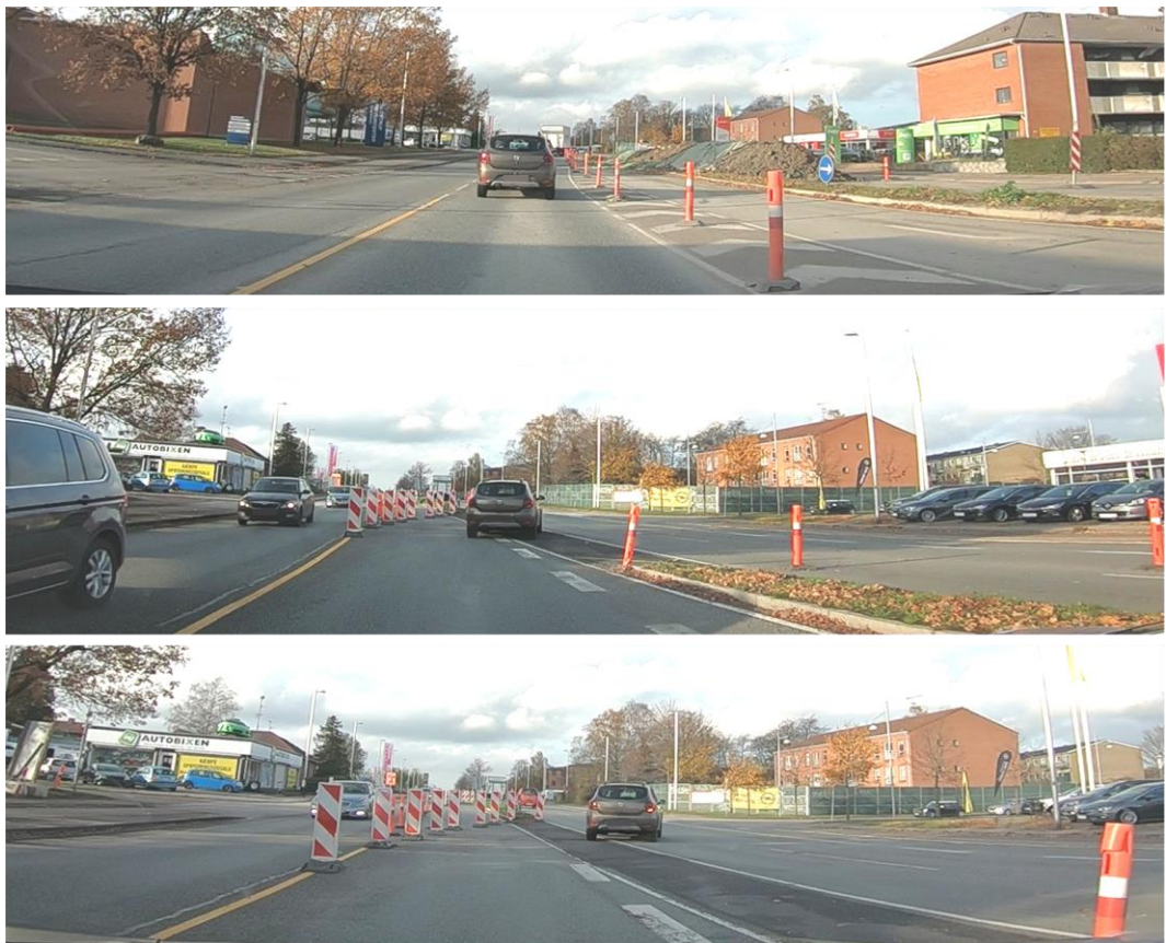
Figur 50. Trafikanter mod vest er overledt til modsatrettede kørebanelhalvdel og tilbageledes efter cirka 150 meter (nederst).
