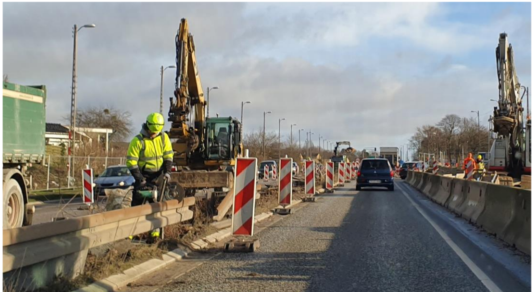
Figur 12. Helhedsindtrykket er klart, og man er som trafikant ikke i tvivl om, hvor man skal køre. Og selvom N42 tavlerne fejlagtigt viser, at man skal køre venstre om tavlen, ind mod vejarbejderen, er der ingen trafikanter, der gør det i dagslys (foto: Trafitec).
