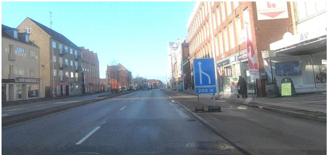
Figur 37. Uhensigtsmæssig placering af oplysningstavle E16.1.3 med undertavle placeret på gummifødder på cykelstien. Tavlen angiver at antal vognbaner reduceres fra to til én 200 meter længere fremme.
