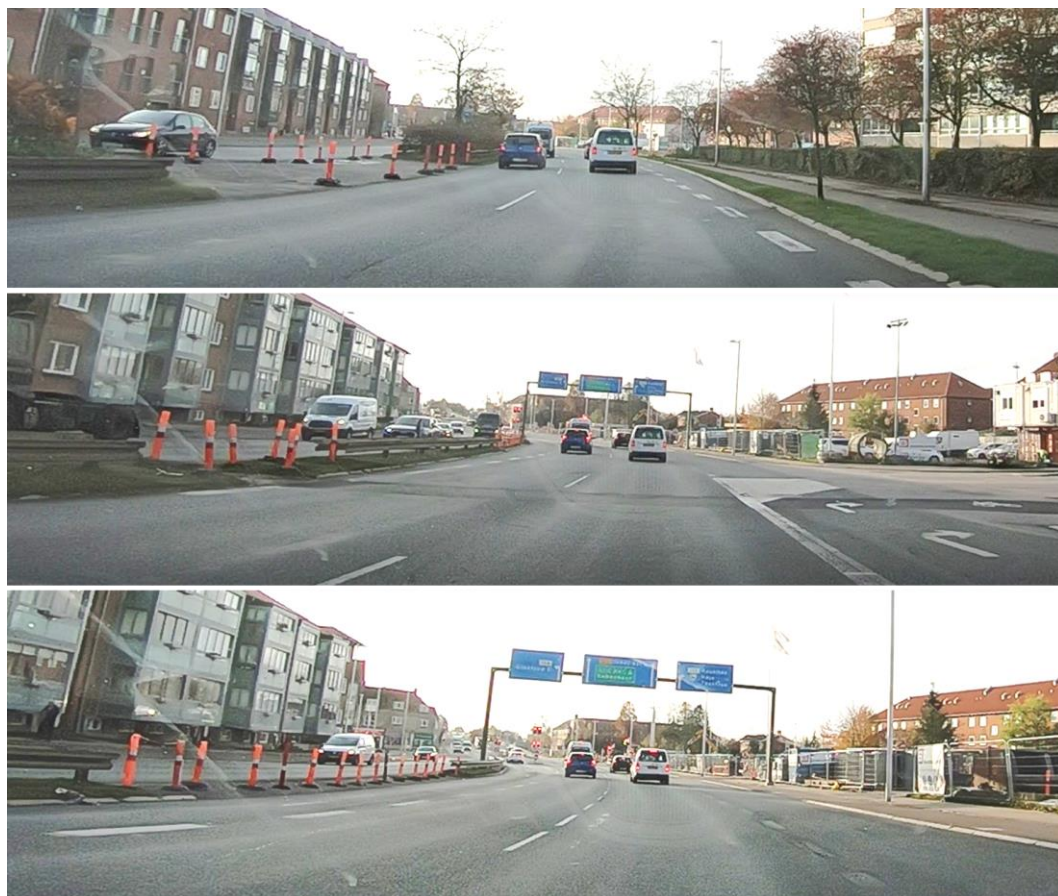
Figur 53. Cirka 230 meter før Ringsvejskrydset i sydgående køreretning er der synligt vejarbejde tre steder i midterrabatten, hvor der er opstillet afspærringscylindre.
