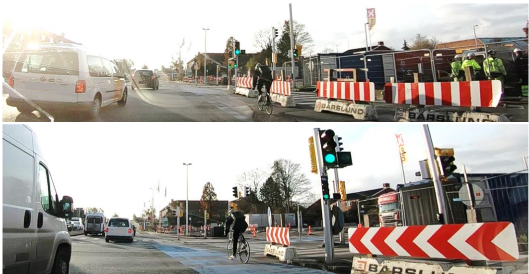
Figur 56. Øverst ses spærrebomme og nederst retningspile. På retningspilen længst fremme er der placeret en påbudstavle D15,2.
