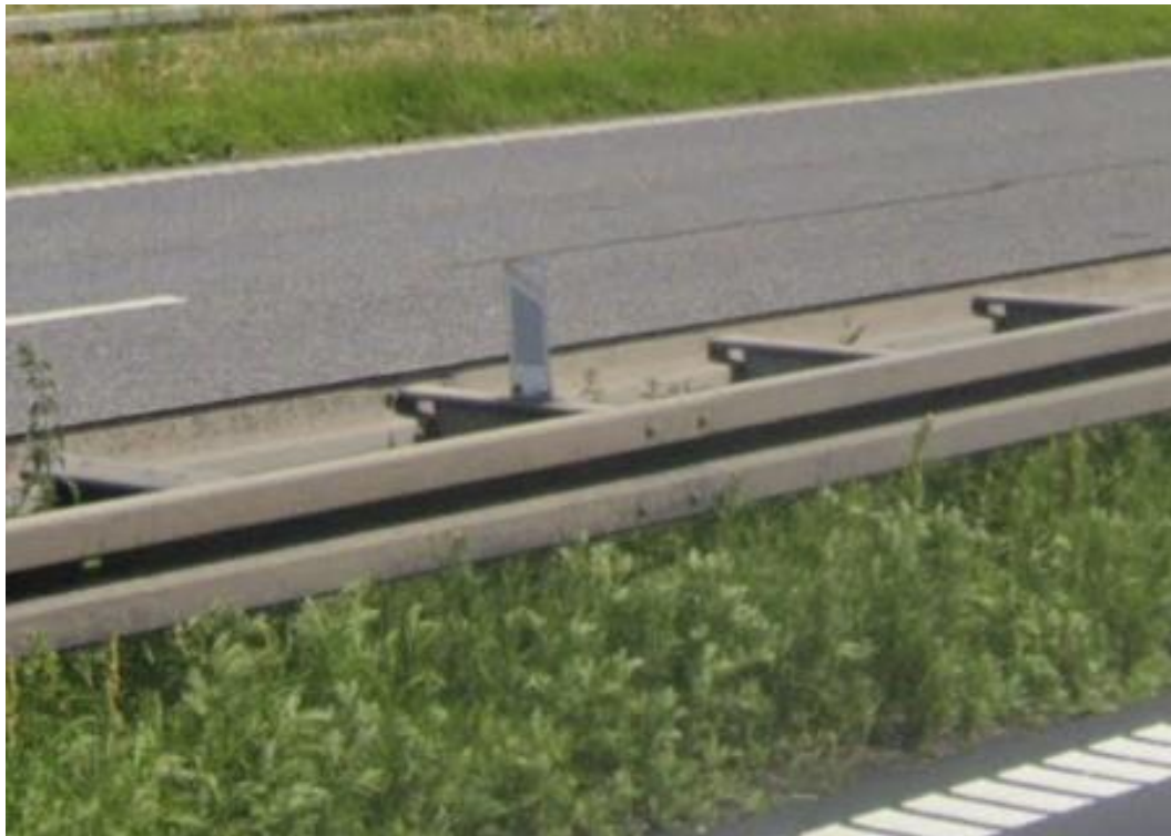
Figur 2: Flapkantpæl i aluminium påsat en tværbjælke i et dobbeltsidet autoværn.
