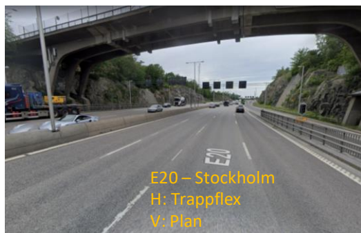
Figur 8: Svenske eksempler på længdeafmærkning på motorvej. <150 m fra by på de øverste to eksempler. <100 m til boliger samt vejbelysning på de nederste fire eksempler (Google Street View).
