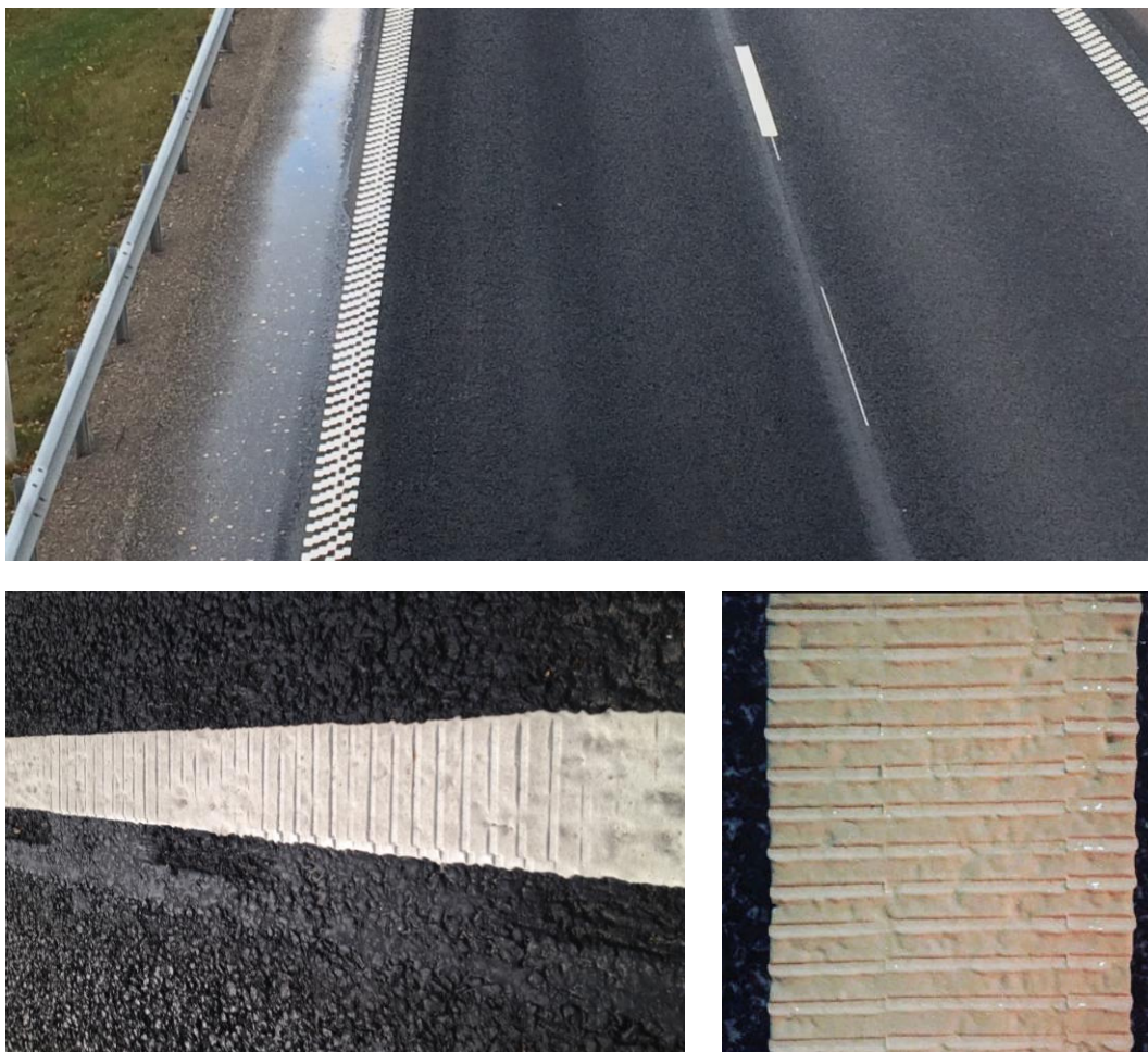
Figur 6: Øverst: kantlinjer med trappflex på motorveje, udføres også på veje uden midteradskillelse. Nederst: plan stribe profileret med ribber – af det venstre billede synes det at være i kombination med fræsede rumleriller. Bredden indikerer, at det er motorvej eller vej med midteradskillelse (billeder tilsendt fra Sverige).
