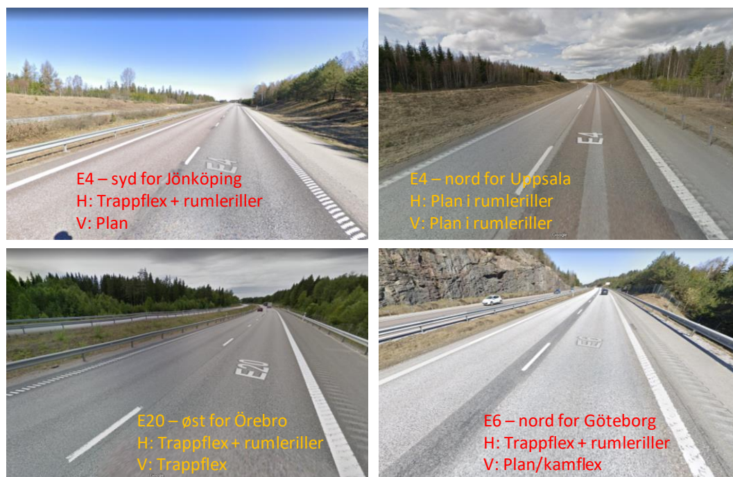
Figur 9: Eksempler i Sverige på længdeafmærkning på motorvej >1 km til by og flere hundrede meter til nærmeste beboelse (Google Street View).
