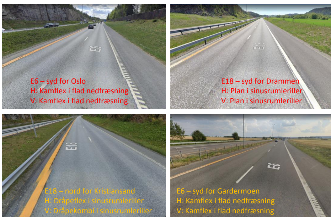
Figur 19: Norske eksempler på længdeafmærkning på motorvej \geq 1 km til by og flere hundrede meter til nærmeste beboelse. Vejbelysning på alle fire strækninger. Det er lidt usikkert, om striber er placeret i et nedfræset fladt spor eller i en nedfræset sinusrumlerille (Google Street View).
