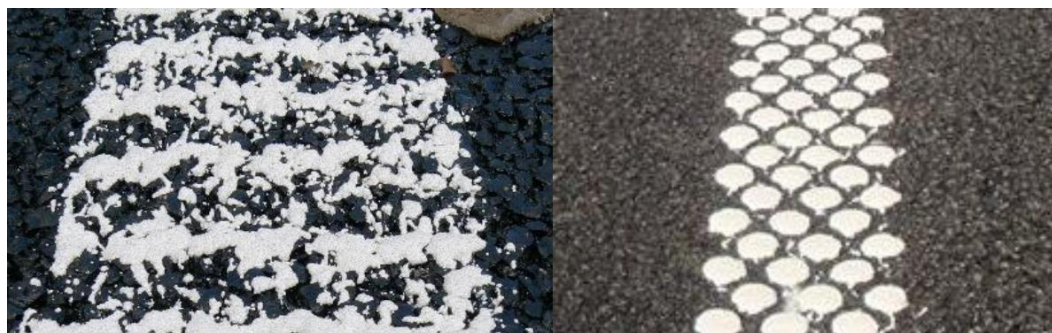
Figur 13: Eksempler på type II afmærkninger med det tilfældige mønster til venstre og det strukturerede dot mønster til højre (van der Aa m.fl., 2016).
