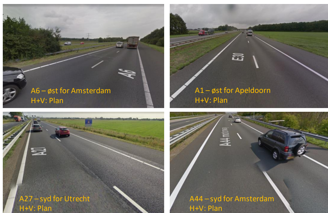
Figur 15: Eksempler på længdeafmærkning på motorvej >1 km fra by og flere hundrede meter til nærmeste beboelse i Holland. På eksemplet øverst til højre er der kun ca. 200 m til beboelse, og på eksemplet nederst til højre er der kun ca. 500 m fra by. Der er ikke vejbelysning på de to øverste eksempler (Google Street View).
