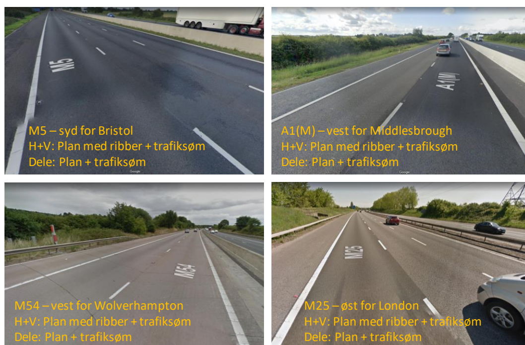
Figur 12: Eksempler i Storbritannien (venstrekørsel) på længdeafmærkning på motorvej \geq 1 km fra by og flere hundrede meter til nærmeste beboelse (Google Street View).
