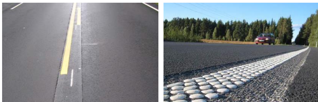
Figur 17: Længdeafmærkning placeret i nedfræsede rumleriller (forstærket afmærkning) på billedet til venstre og i et nedfræset fladt spor på billedet til højre (Giæver, 2011).
