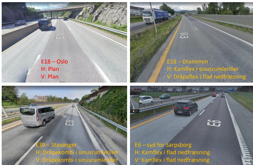
Figur 18: Norske eksempler på længdeafmærkning på motorvej <100 m fra by/beboelse. Vejbe-lysning på alle fire strækninger. Særligt på de to eksempler til højre er det lidt usikkert, om striben er placeret i et nedfræset fladt spor eller i en nedfræset sinusrumlerille (Google Street View).
