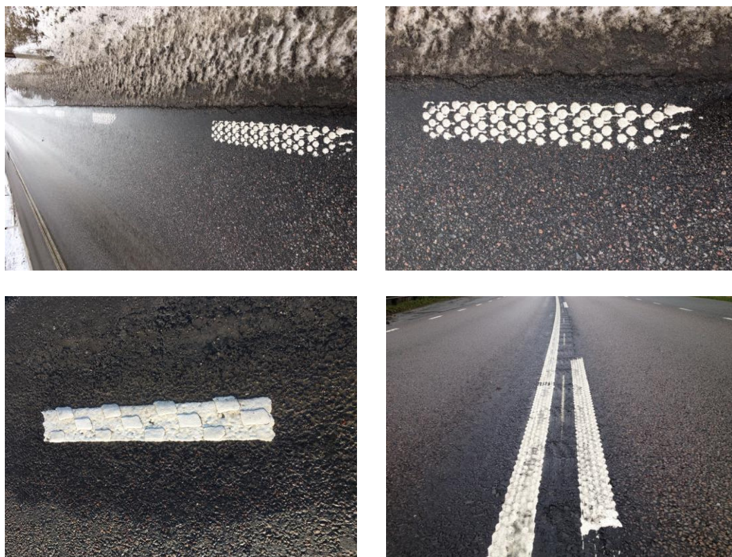
Figur 7: Eksempler på profilerede linjer på 2-sporede veje. Øvers: dråbemønster i kantlinje, nederst venstre: plan kantlinje med profilering i trappflex, nederst højre: midtlinje placeret i fræsede rumleriller – plan stribe med profilering i dråbemønster.
