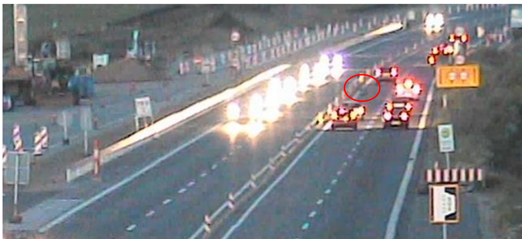
Figur 43: Tabt genstand i form af et trillende hjul (markeret med rød ring) er sammen med overledningsstrækning (genstanden ville være stoppet af midterrabatten ved "normal" adskillelse af køreretningerne) medvirkende årsag til ulykke.
