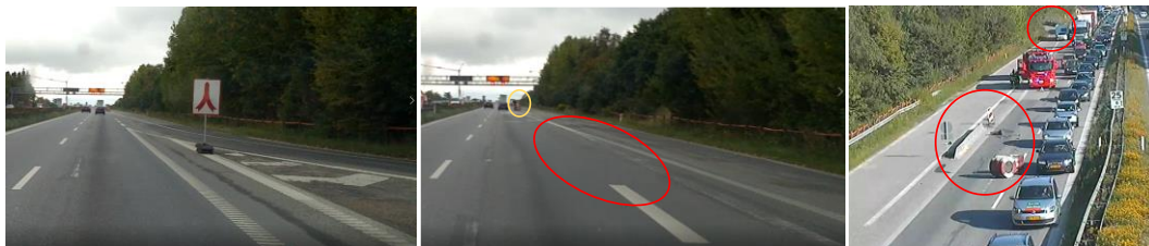
Figur 37: Dårlige oversigtsforhold mellem rampetilkørsel og motorvej i kombination med kort rampe vurderes at have været medvirkende til ulykkens opståen. Venstre foto: Rampetilkørsel. Foto i midt: Enden af tilslutningsrampe. Bagest i billedet antydes dæksæt (markeret med gul ring). Højre foto: Forrest ses det påkørte trafikværn og dæk, bagest rampetilkørslen.
