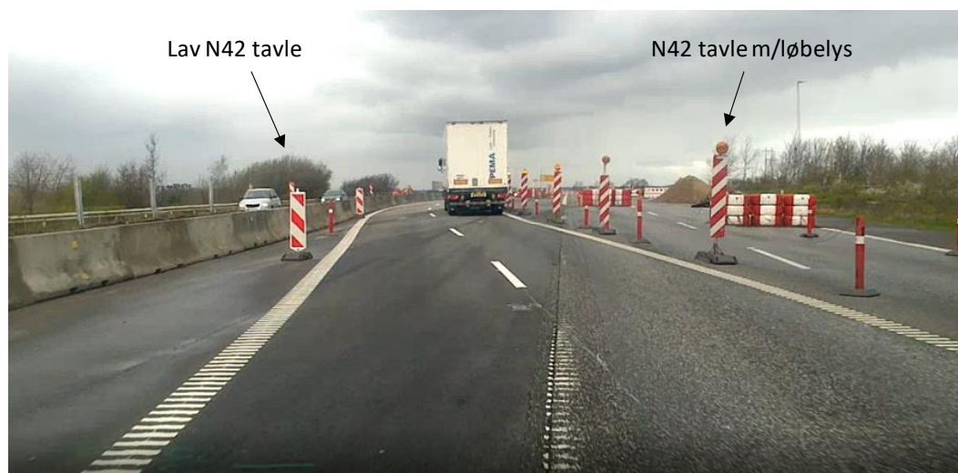
Figur 6: Mindre gode oversigtsforhold i kurven har gjort det svært for trafikanterne, at erkende pludseligt stop i trafikken. Oversigtsforholdene forringes markant i tæt trafik.
