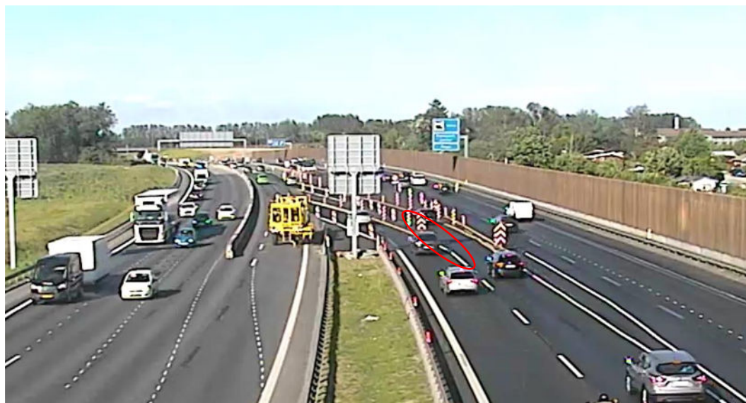
Figur 26: Den røde ring markerer den korte spærrelinje. N42-tavler og N43-tavle er ikke trukket tilbage før kurvestart mellem spor 3 og 4.
