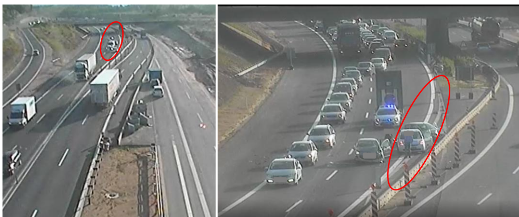
Figur 18: Sporbortfald i kurve kort før forsætning og kort efter brooverførelse vurderes at have mindsket trafikanternes oversigtsforhold på ulykkeslokaliteten. Yderligere vurderes sporbortfaldet at være etableret over en for kort strækning, afmærkningen vurderes mangelfuld, mens ringe demarkering af kantlinje vurderes at fremstå vildledende (markeret med rød ring på foto til højre).
