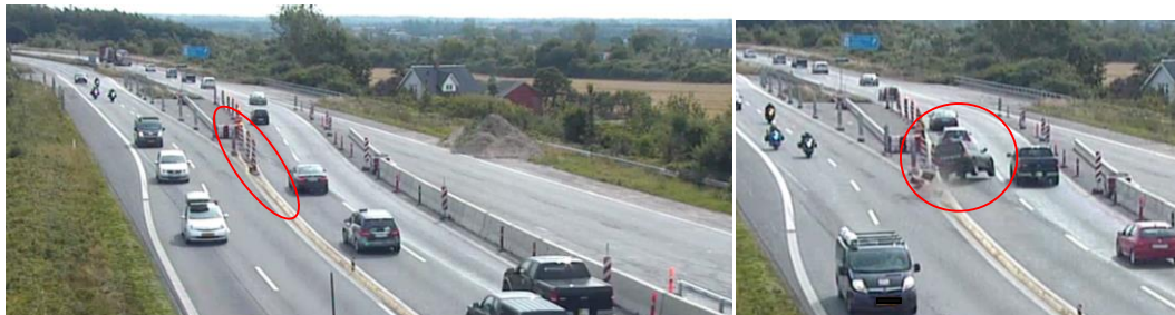
Figur 14: Foto til venstre: Den røde ring markerer, hvor N42-tavler med fordel kunne være ført tilbage til kurvestart – det vurderes dog ikke at være afgørende for denne ulykke. Foto til højre: Rød ring markerer bilisten, som mister herredømmet.
