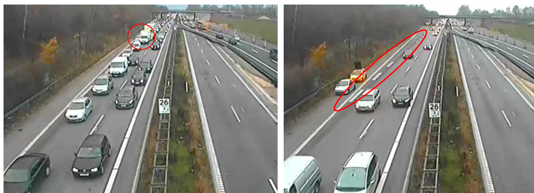
Figur 38: Venstre foto: Ulykke ved indfletning fra rampe. Højre foto: Den røde ring markerer spøgelses- og vildledende afmærkning mellem rampens kilestrækning og motorvejens højre spor. Afmærkningen vurderes dog ikke at have haft betydning for ulykkens opståen.
