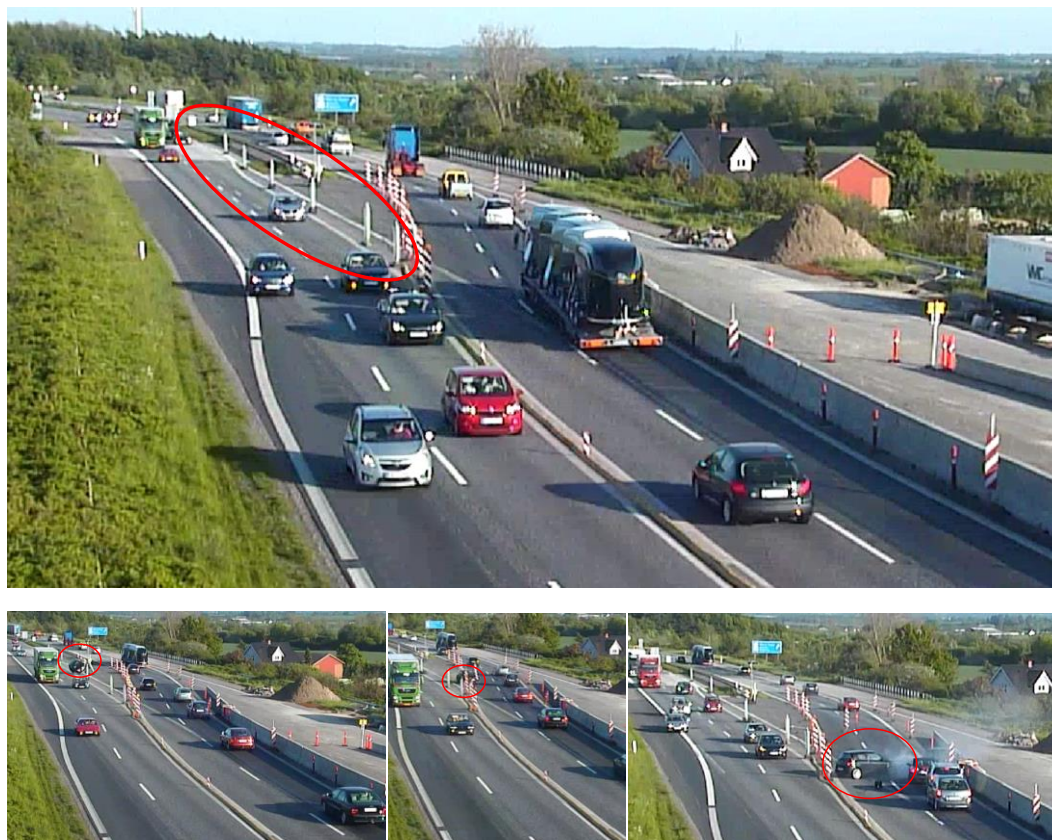
Figur 7: Foto øverst: Den røde ring markerer problematikken på ulykkeslokaliteten: Gammel kantlinje i forsætningen, for stor afstand mellem N42-tavler samt manglende tilbagetrækning af N42 tavlerne opstrøms, således at de placeres et stykke før kurvestart. Desuden kan spøgelsesafmærkning fra gamle vognbanelinjer i spor 1 antydes. Ulykken forværres af, at der ikke er trafikværn i selve overledningen. Fotoserie nederst: Rød ring markerer køretøjet som kører gennem overledningen og over i modsatte kørebanelid, hvor den holder på tværs efter kollision med modgående trafikanter.
