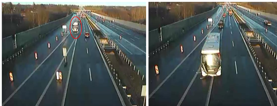
Figur 27: Vekselsestrækningen slutter kort før N43-tavle uden forudgående spærrelinje eller fuldt optrukket kantlinje. Den røde ring markerer bus, hvis chauffør foretager sent vognbaneskift pga. af den vildledende afmærkning og blændingen fra sol.
