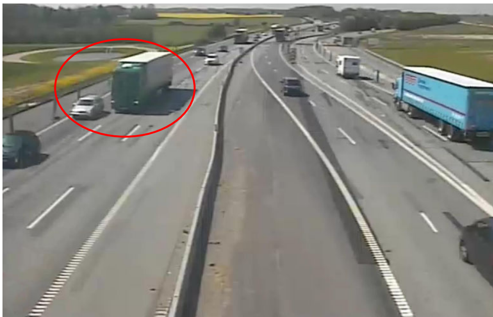
Figur 39: Vognbaneskift fra midterste til højre spor kan være kompliceret for tunge køretøjer, når lastbilchaufføren også skal være opmærksom på smalle spor og en S-kurve, som måske først registreres sent i forløbet. Den røde ring markerer ulykkeslokaliteten og to af de ulykkesinvolverede. Bemærk i øvrigt spørgelsesafmærkningen i begge køreretninger.
