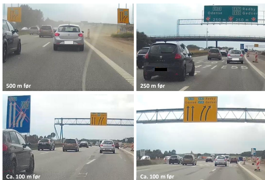
Figur 59: Vejvisning på de sidste 500 m frem mod forgrening. Blanding af midlertidige gule tavler og permanente blå og grønne tavler med annullering. I dette eksempel vil trafikanterne opleve, at både de permanente og de midlertidige tavler viser det samme, til trods for at de permanente tavler er annulleret. Det kan skabe forvirring om den gældende vejvisning.
