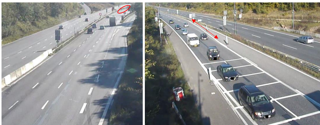
Figur 21: Vejudformningen vurderes uhensigtsmæssig i forhold til placeringen af sporbortfald (markeret med rødt): Sporbortfaldet er etableret i en højre kurve for enden af en nedadgående bakke og er noget svagt afmærket set i forhold til denne udformning. Bemærk i øvrigt, at der er etableret rumleriller efter /nedstrøms sporbortfaldet, og at selve sporbortfaldet er svagt markeret med blot 3 N42-tavler.
