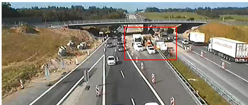
Figur 52: Det kan ikke udelukkes, at stor vejarbejdsaktivitet, som fx her i midterabatten (rød firkant), kan distrahere trafikanterne og føre til uopmærksomhed på trafikken. Det er imidlertid meget få af undersøgelsens ulykker, der rent faktisk er sket på steder med stor vejarbejdsaktivitet, og kun i forbindelse med én ulykke, at det ikke kan afvises, at der er en sammenhæng mellem ulykke og stor vejarbejdsaktivitet.
