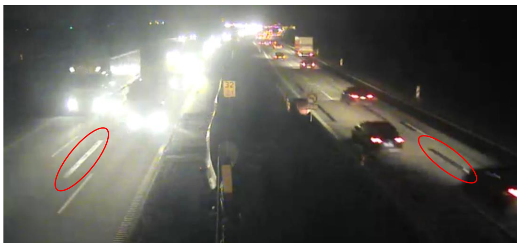
Figur 55: Eksempel på hvordan spøgelsesafmærkning kan fremstå i mørke (markeret med røde ringe).
