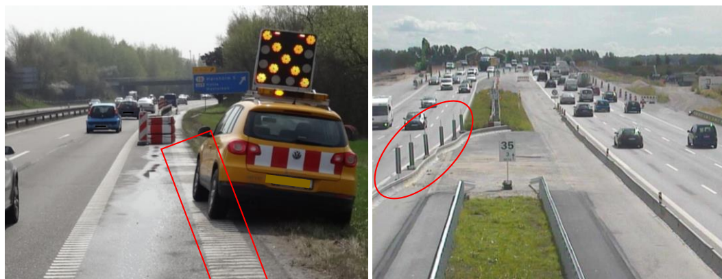
Figur 13: Foto til venstre: Den gamle kantlinje (markeret med rød ramme) kan, eventuelt i kombination med den nye kantlinje og frakørselstavlen, foranledige trafikanten til at tro, at det er starten på frakørselsrampe. Foto til højre: Den røde ring markerer forsætningen og antydningen af spørgelsesafmærkning fra gamle vognbanelinjer. Forsætningen er ikke forvarslet og forekommer overraskende for flere trafikanter.
