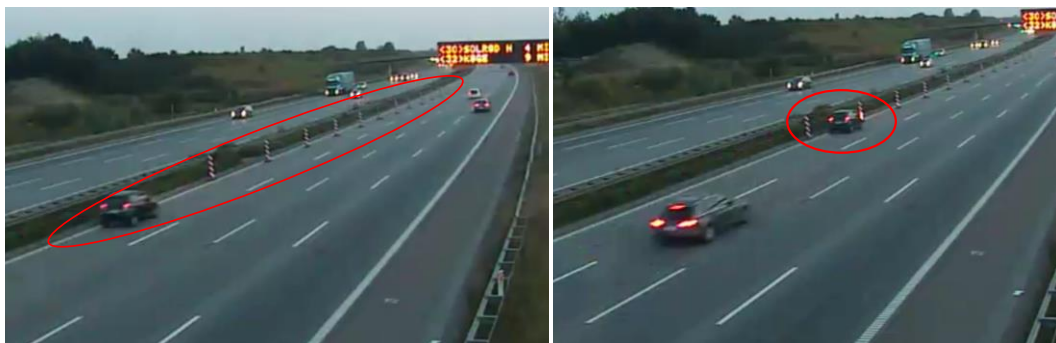
Figur 20: I tusmørket fremstår N42-tavlerne, idet løbelyset er defekt. Kantlinjen vurderes at fremtræde mere tydelig end begrænsningslinjen. Venstre foto: Den røde ring markerer begrænsningslinjen, og bilisten som forulykker. Højre foto: Bilisten lige før første N42 tavle påkøres.
