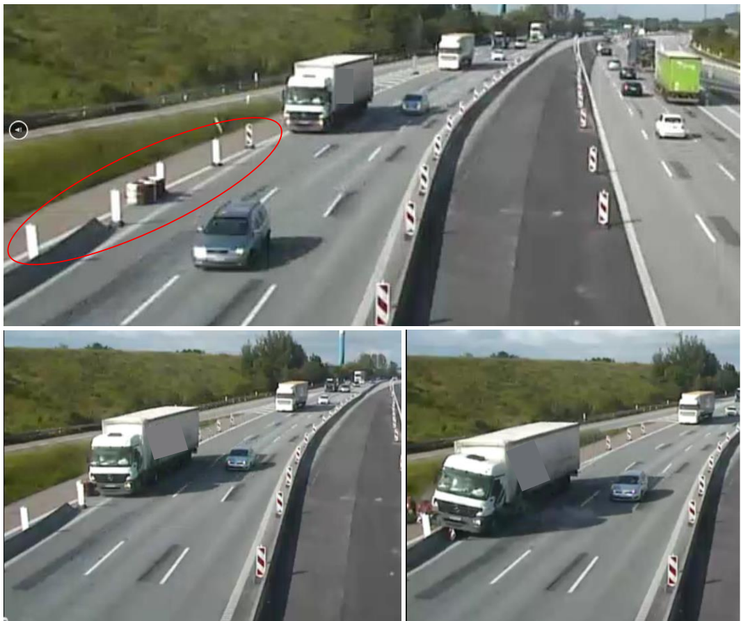
Figur 10: Den røde ring markerer den problematiske afmærkning: Gammel kantlinje og N42-tavler placeret langs denne vildleder trafikanterne. Nederst ses lastbil der følger den gamle kantlinje og fortsætter ligeud i en S-kurve, hvor vejen forsættes mod venstre.
