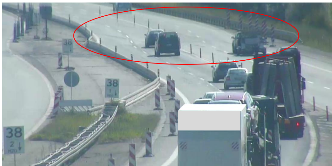
Figur 9: Den røde ring markerer problematikken: Forsætningen er etableret umiddelbart før sammenløb. Forsætningen er ikke tilstrækkeligt afmærket i højre side, hvor N42-tavler er placeret for langt til højre for kantlinjen. I venstre side består forsætningens afmærkning af steler mellem de to vejgrene.
