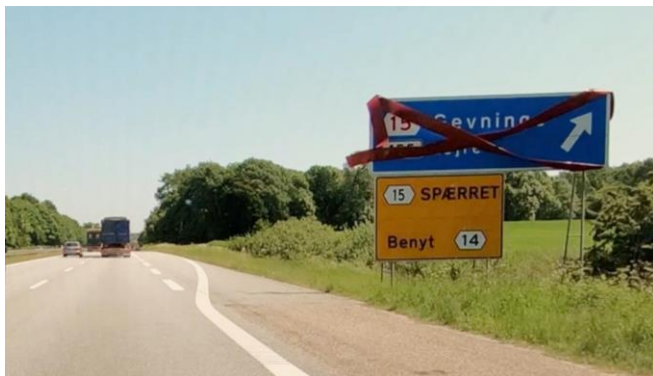
Figur 3.5: Rampen er ikke fysisk afspærret med N42 tavler
