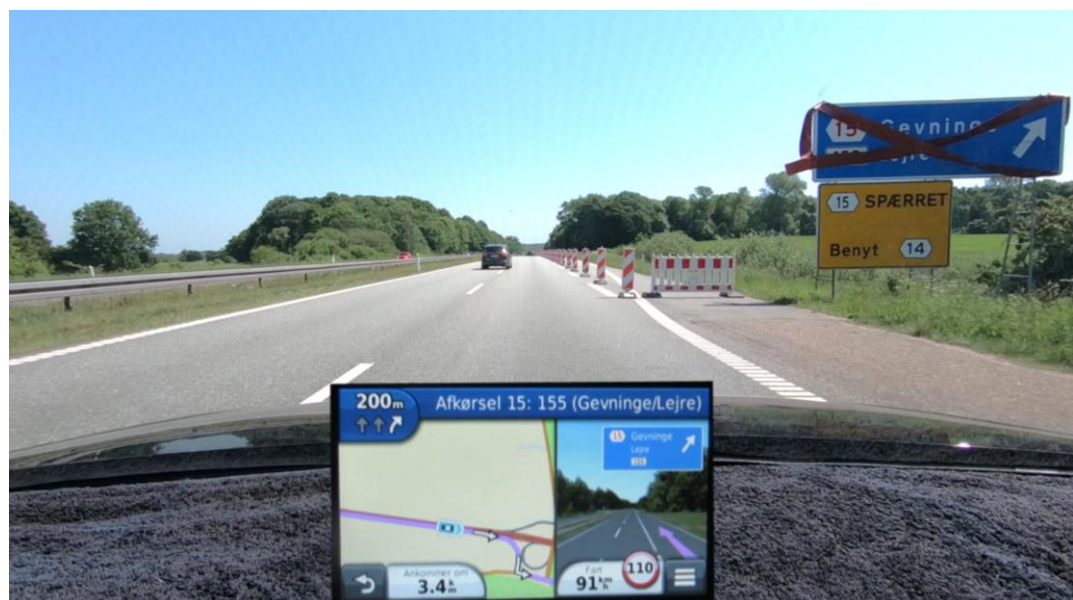
B1.8: Frakørsel <15> Gevninge MED AFSPÆRRING af rampe med N42 tavler samt gul informationstavle sammen med annulleret blå frakørselstavle.
