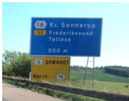
Figur 3.2: Gul tavle informerer om, at frakørsel <15> er spærret, og at frakørsel <16> kan benyttes i stedet for.
