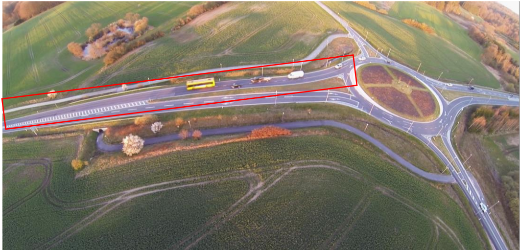
Figur 2.2 Dronefoto af rundkørsel i Fredensborg (RK2) med angivelse af den undersøgte frafart.
