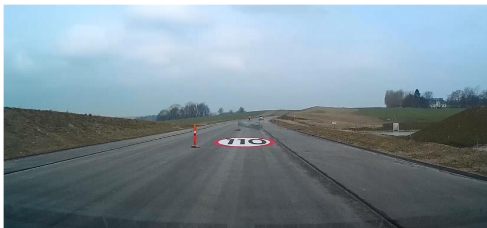
Figur 4.7: Farvet hastighedssymbol (med tallet 110) designet med smal rød ring og symbolhøjde 9,0 m.
