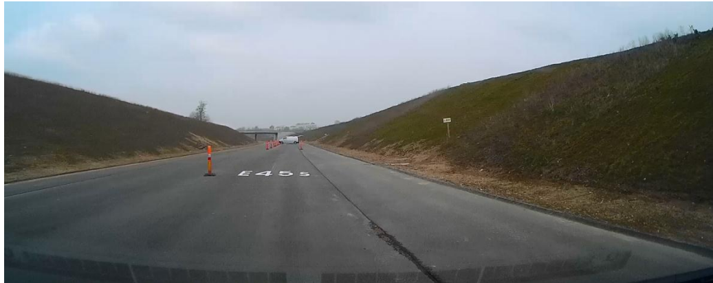
Figur 4.37: Rutenummer E45 i H=2,4 m kombineret med kompasretning lille "s".
