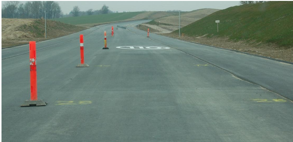
Figur 4.13: Hvidt hastighedssymbol (vist med tallet 110) med symbolhøjde på 7,0 meter.
