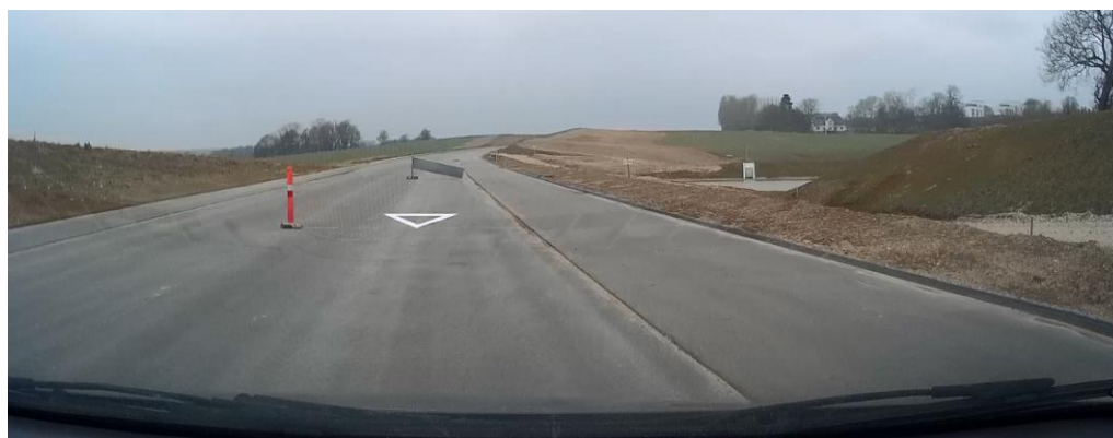
Figur 4.23: Trekantsymbol med symbolhøjde 3,0 meter.
