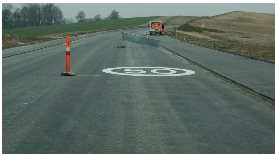
Figur 4.11: Hvidt hastighedssymbol (med tallet 50) med symbolhøjde på 4,0 meter
