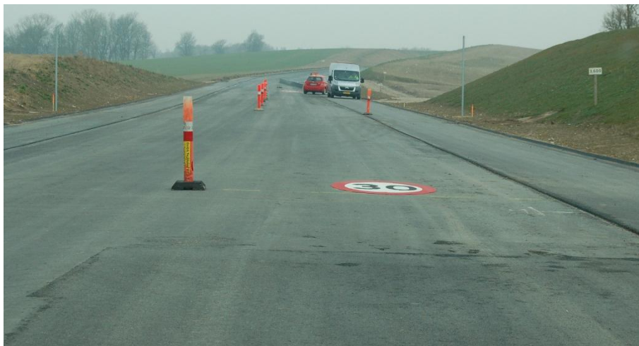
Figur 4.1: Farvet hastighedssymbol med symbolhøjden 2,4 meter
