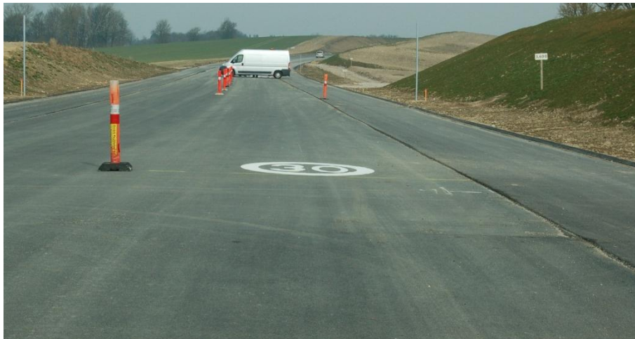
Figur 4.9: Hvidt hastighedssymbol (med tallet 30) med symbolhøjden 2,4 meter.
