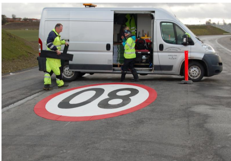
Figur 2.2: Udlægning af symbolet i premark.
