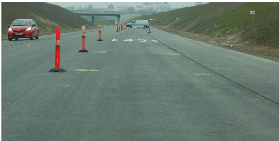
Figur 4.45: Rutenummer E45 i H=6,0 m kombineret med kompasretning lille "s".
