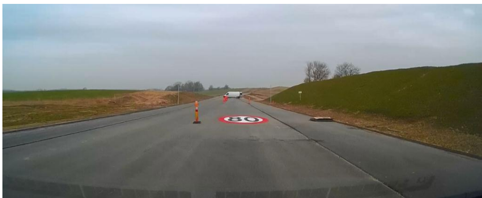
Figur 4.5: Farvet hastighedssymbol (med tallet 80) designet med smal rød ring og symbolhøjde 7,0 meter
